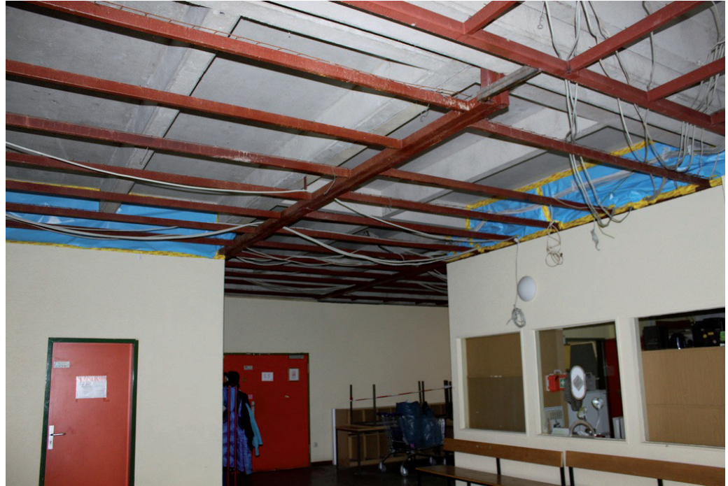
Auch alle Deckenplatten werden erneuert
